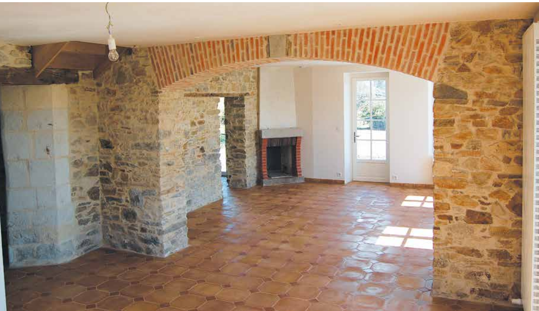
Le séjour terminé. Espace et lumière donnent une touche contemporaine à l'ensemble, réalisé avec des matériaux nobles.
