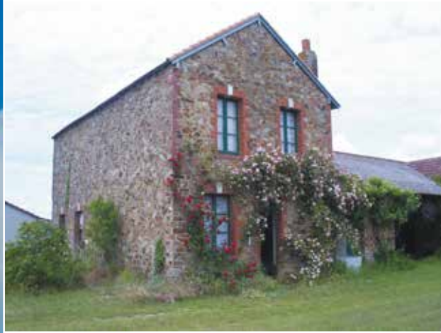
La maison avant travaux : aucune ouverture au sud !
